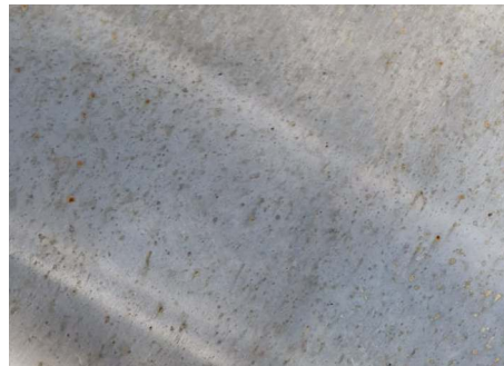
Arbeiten mit dem Winkelschleifer an verzinkten Trägern und folgend Eisenspan-"Einschüsse"
